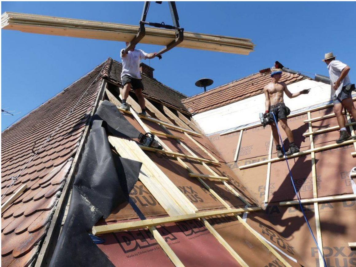
Beginn der Arbeiten an der Südostseite des Daches
