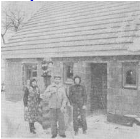
Der Rohbau der Familie Zehetmaier
