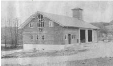
Rohbaus des Thalheimer Feuerwehrhauses
