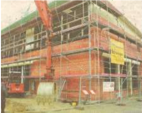
Der Reichenkirchner Schulneubau
