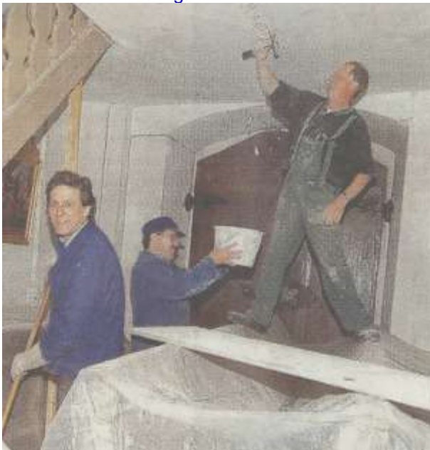
Kirchenrenovierung in Reichenkirchen
