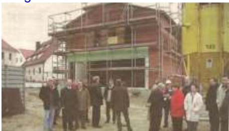
Der Rohbau des Pfarrheimes in Maria Thalheim
