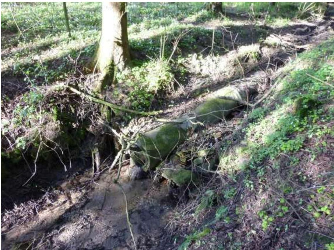
Abbildung 11: Gewässerdurchgängigkeit durch alte Verrohrung unterbrochen
