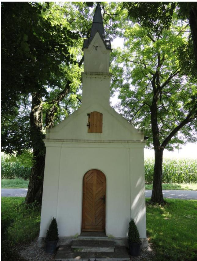
Vor dem Bauernhof des Kaspar Angermeier steht zwischen Laubbäumen eine neugotische Marienkapelle, erbaut zwischen 1870/80. Der Außenbau ist durch gemauerte Pilaster und ein profiliertes Traufgesims gegliedert. Der zweigeschossige Dachreiter über der Westfassade besitzt an seinen vier Wänden Steilgiebel, über denen ein spitzer Turmhelm aufsteigt.
