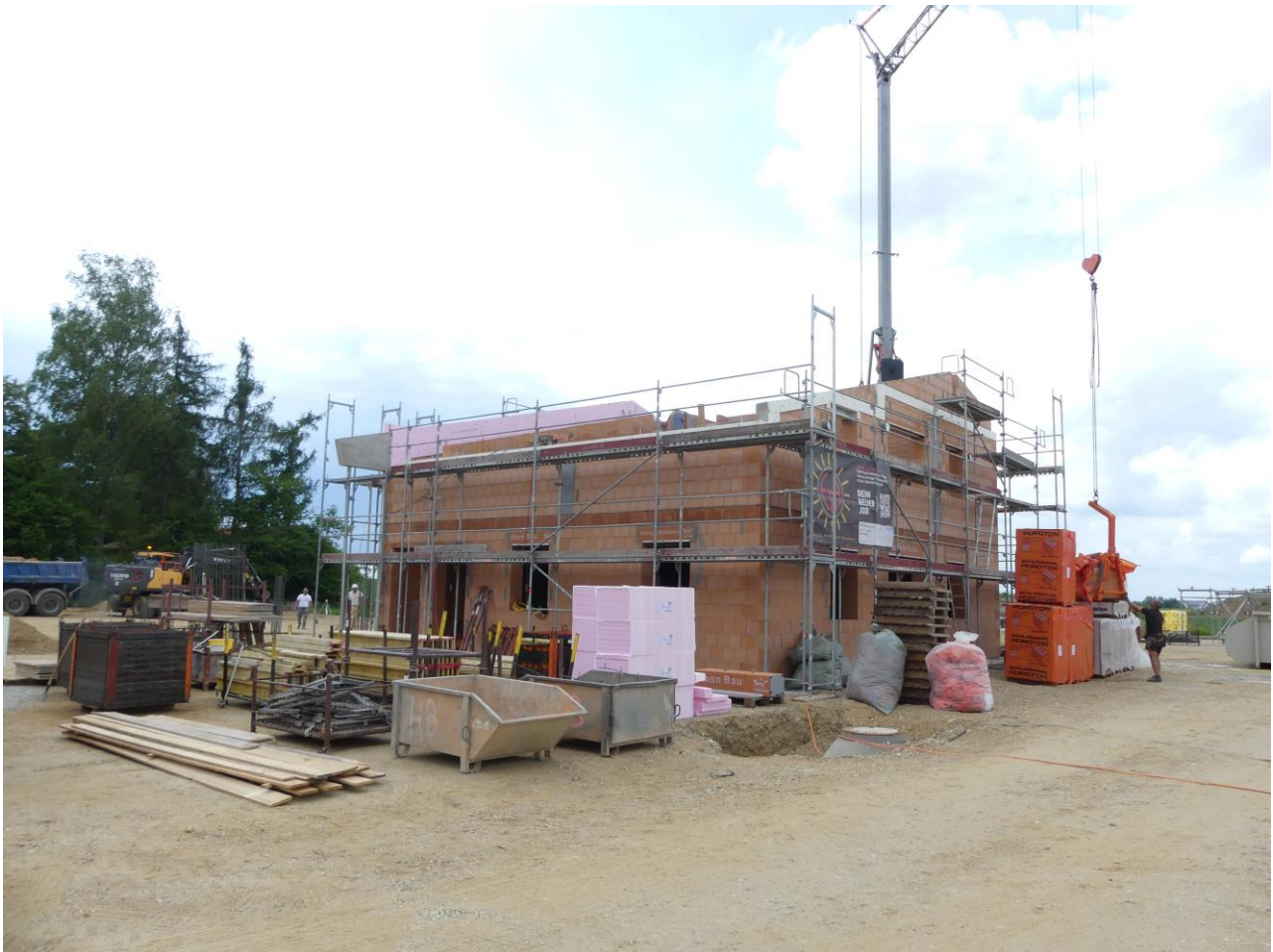
Der Rohbau des Sozialtraktes ist fertiggestellt
