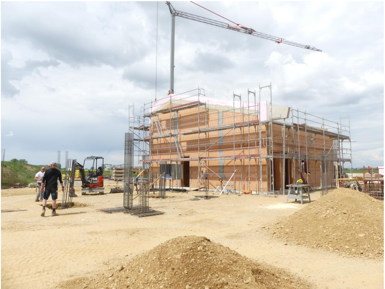
Der Rohbau des Sozialtraktes von Südosten. Die Betonfundamente des angrenzenden Gebäudes sind am Entstehen
