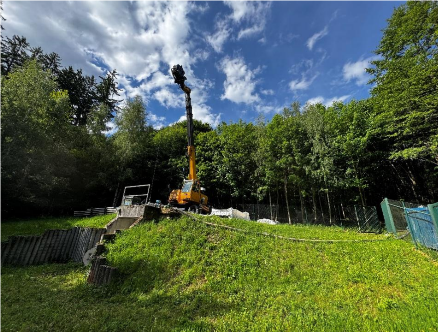
Kran zum Ziehen und Wiedereinbau der Steigleitung samt Pumpe
